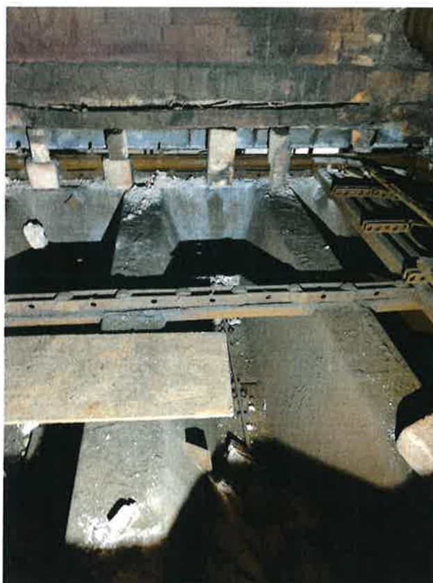
Skrzynia podmuchowa przeznaczona do remontu (zdjęcie pogładowe po zdjęciu rusztu w innym kotle)
