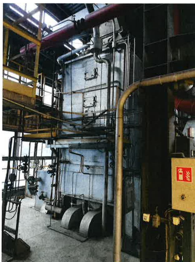
Kocioł WR2 5-035 przeznaczony do remontu
